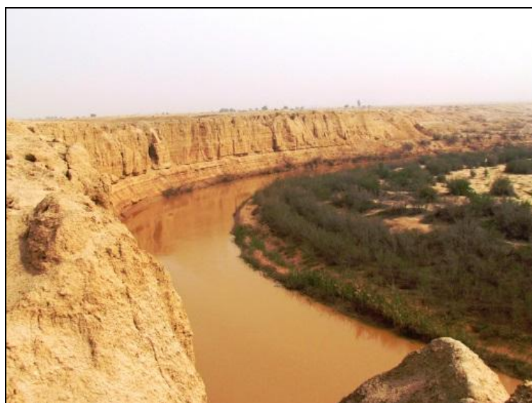
شکل 7. برش‌های عمیق ایجاد شده در کرانه‌های گرگر و اختلاف سطح آب با زمین‌های مجاور (عکس از نگارندگان)
